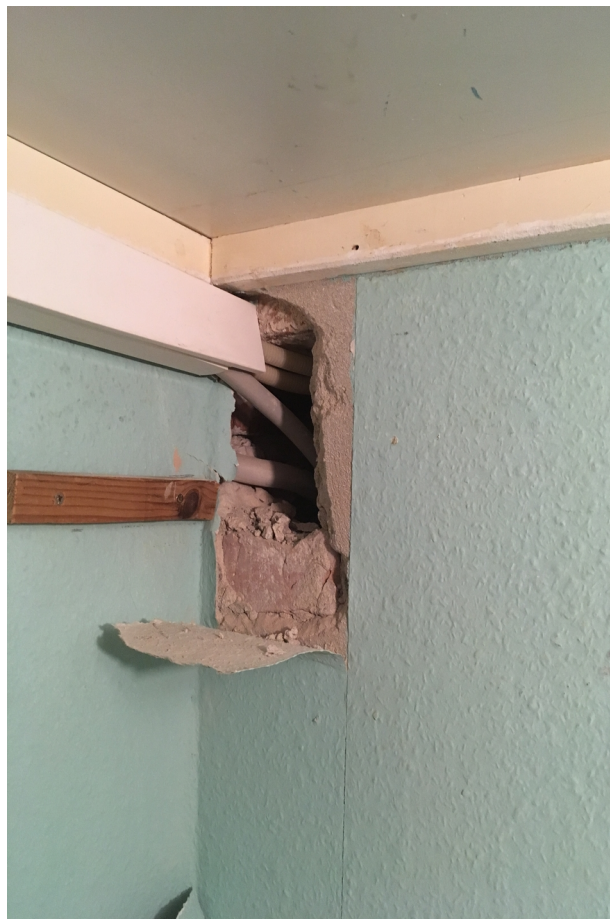
Foto: privat von Akelius-Mieter*innen eines anderen Hauses Zustand nach Modernisierung im Bestand à la Akelius, Elektroleitungen nun über Putz
