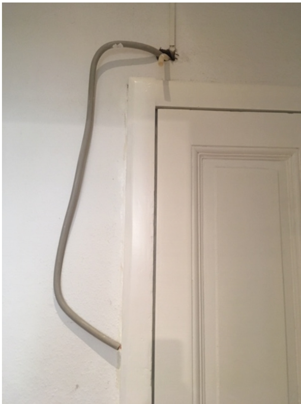
Foto: privat von Akelius-Mieter*innen, frei hängendes Kabel nach Sanierung im Bestand
