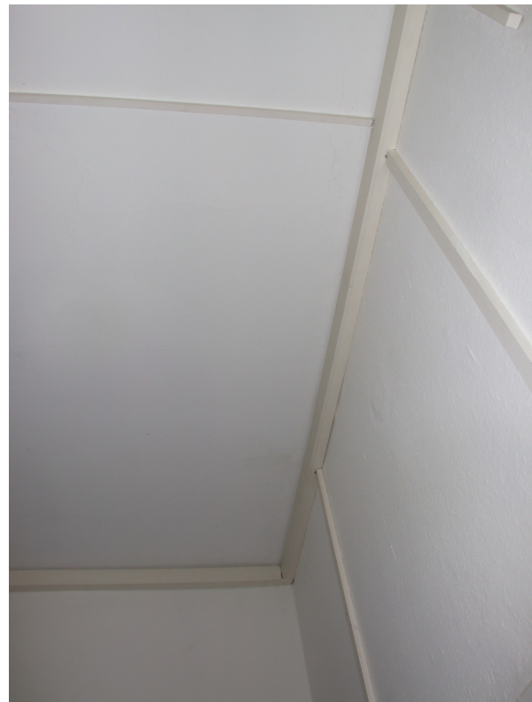
Foto: privat von Akelius-Mieter*innen Überputz-Kabel nach Sanierung im Bestand
